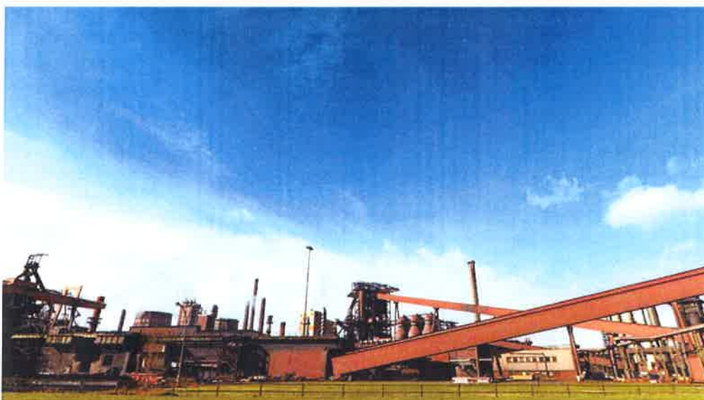
Stahlwerk von Salzgitter
